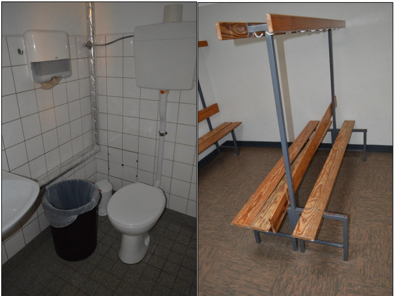
Abbildung 34. „Turnhalle, Bickbargen 115/Grundschule Bickbargen“
